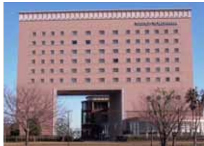
落ち着いた 高層部の壁面看板
